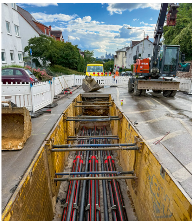
Energieadern der Stadt: In zwei bis acht Metern Tiefe werden die Stromkabel quer durch die Innenstadt verlegt.
